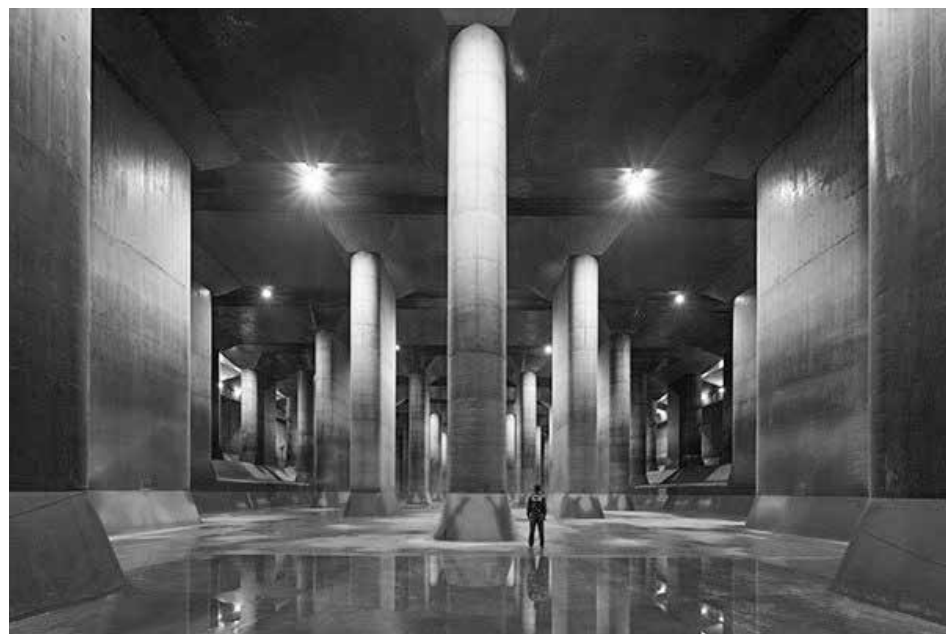
図表2 首都圏外郭放水路（調圧水槽）
