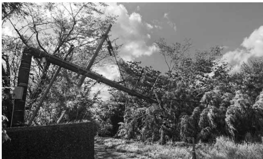
千葉県南部地域では強風で数多くの電柱が倒壊した
