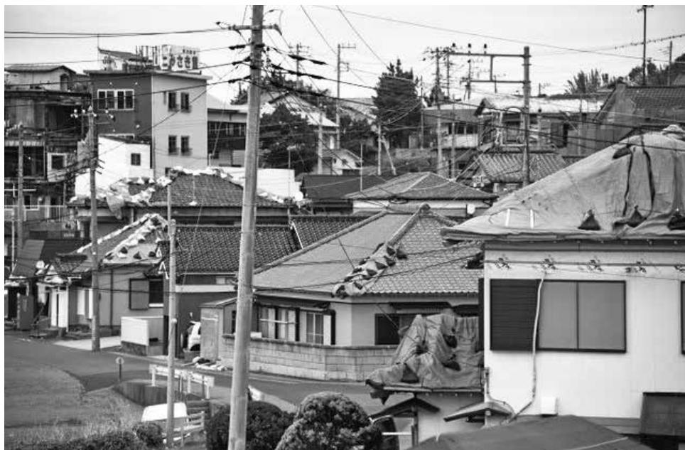
図表4 壊れたままの被災住宅
