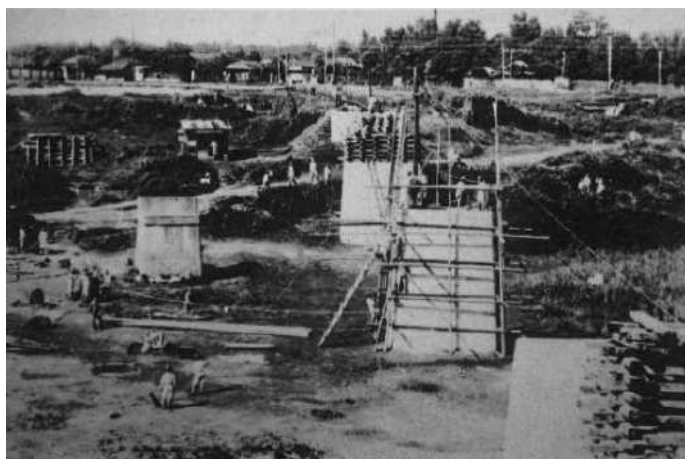
綿打池での架橋訓練
