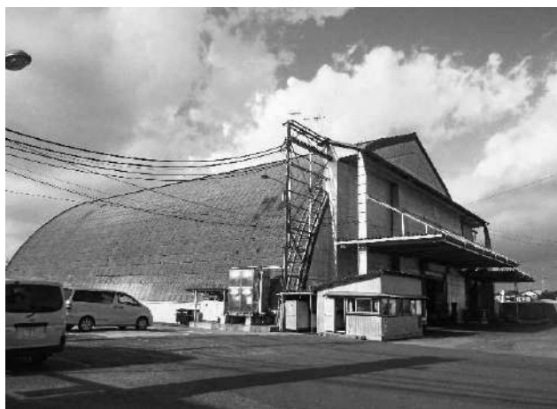
旧第二格納庫（現川光倉庫）
