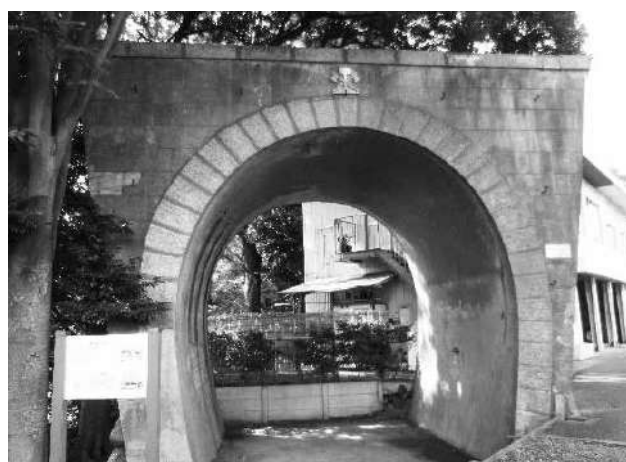
千葉公園に残るトンネル
