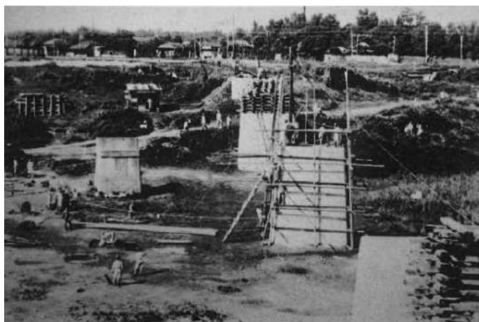
綿打池での架橋訓練
