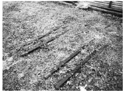
材料廠への引込み線 (軽便線—内側、狭軌線—外側)
