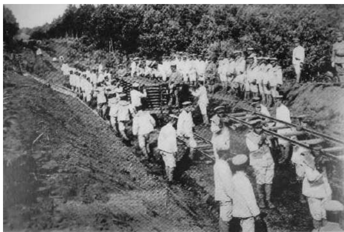
線路の敷設訓練 *軌匡を担ぐ
