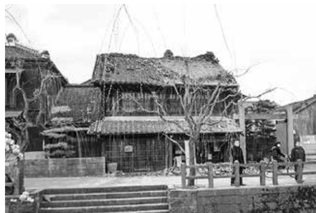
図表14 佐原の町並みの被害状況（写真）
