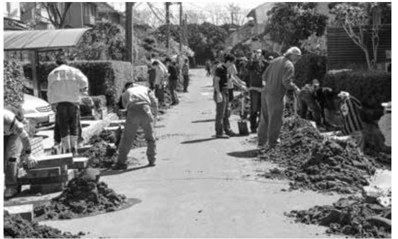
図表18 土砂撤去作業（写真）
