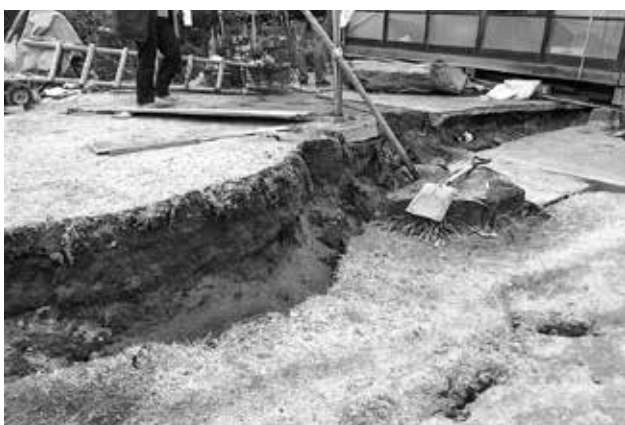
図表9 利根川左岸(新島地区)液状化被害②(写真)
