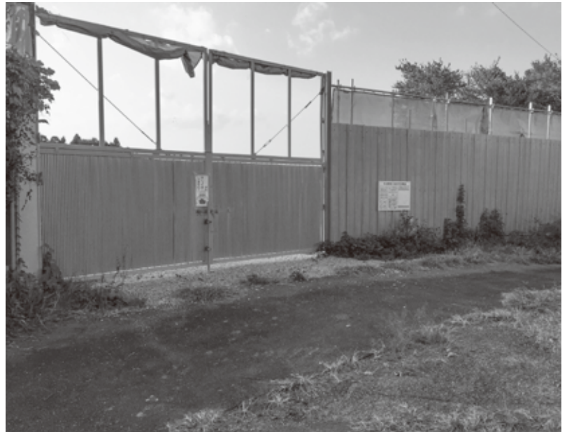
図表3 埋め立て現場の入り口《2016年12月》(写真)
