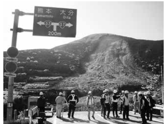
図表3 地震で大崩落した国道57号線（写真）
