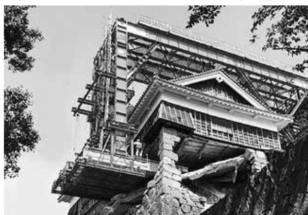
図表8 飯田丸五階櫓崩壊防止工事（写真）
