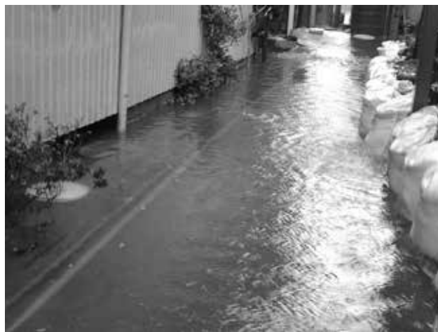
図表12 未曾有の液状化被害—垂直沈下型被害(写真)
