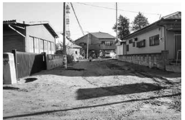
図表10 利根川右岸(下川岸地区)の液状化被害(写真)
