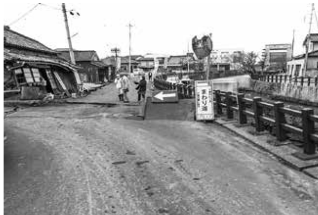
図表13 利根川右岸(小野川河口付近)の液状化被害(写真)
