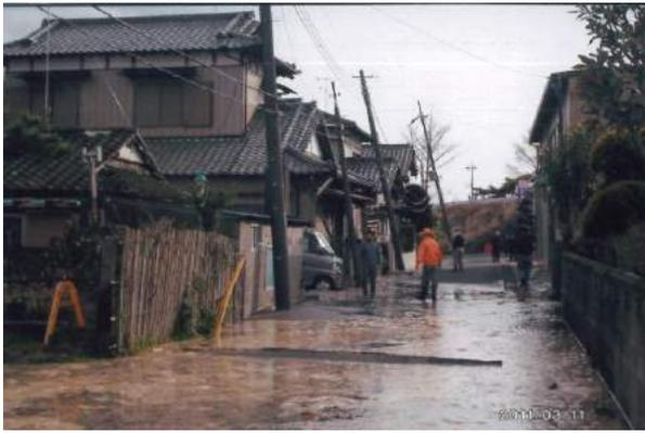
液状化現象による電柱の傾き
