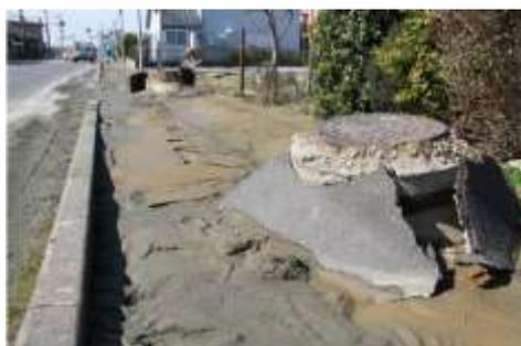
香取市の被害の特 液状化により突出したマンホール
