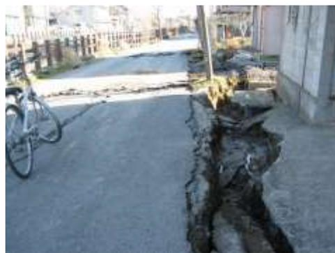
小野川に面した道路や宅地には、川への地盤の側方流動による大きな地割れが生じた
