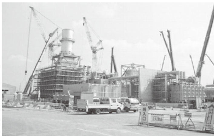
＜千葉火力発電所＞ 緊急設置電源工事
