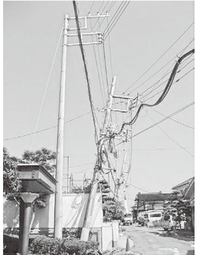
＜傾斜した配電柱＞
