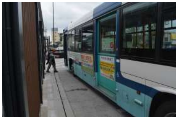
一般車も止まる広場内で、バスが定位置に必ず着けるわけではない。排水の関係からバス停が歩道を同じ高さとなったが、社会的弱者の体への負担になる乗車時の上下方向への体の移動を1回に抑えた。
