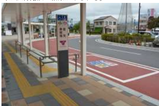
バス停に連続した身障者等乗降場。15cmの高さから車道に擦り付けるためにスロープを設置。その分歩道幅が削られている。
