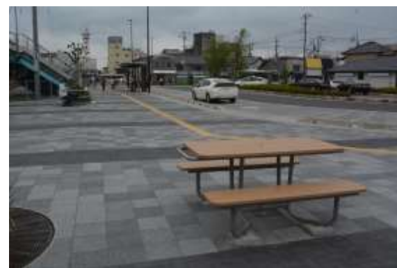
駅前広場内の歩道はフラットにして移動の円滑化を確保。併せて広場内にベンチ（机付き）を設置し休憩スペースを確保した。
