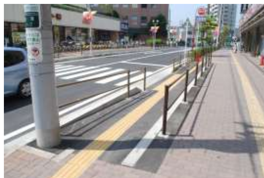
従来のマウンドアップの歩道と横断歩道を擦り付けるためにスロープを設置して、車いす利用者のために横断歩道際の平らな部分を確保。同じく歩道幅が削られている。
