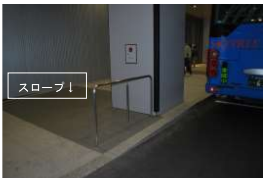
バス停と、通常の歩道の高さの違いを擦り付けるスロープ。車いすからすれば良い。
