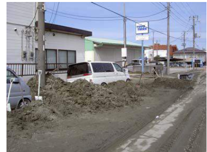
土砂に覆われた道路（新港）
